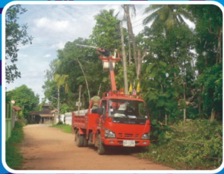
งานบริการซ่อมแซมไฟฟ้าสาธารณะ
